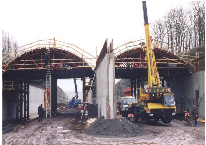
Etude d'un coffrage roulant à Mondorf (L)
