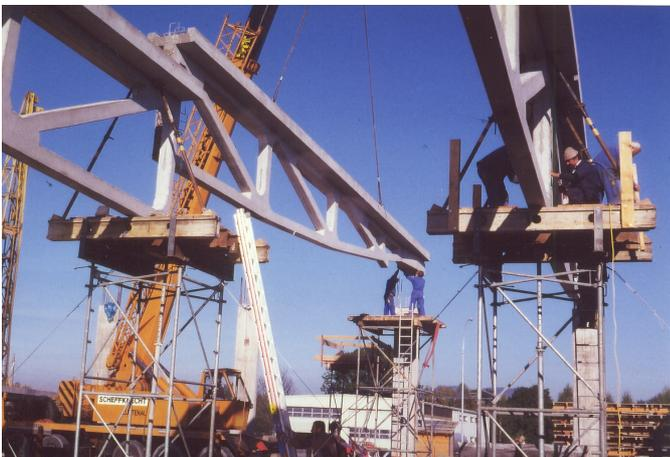
Poutre béton post-contrainte d'une portée de 38m
