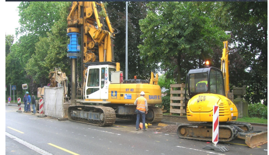
Boulevard de la Pétrusse (L)
