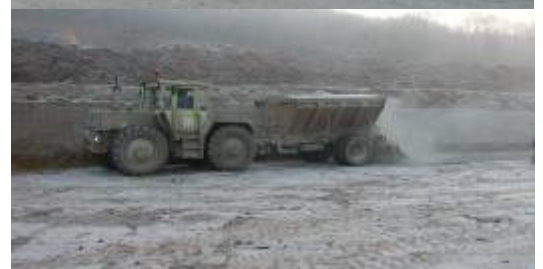
Stabilisation de sols – Dommeldange (L)
