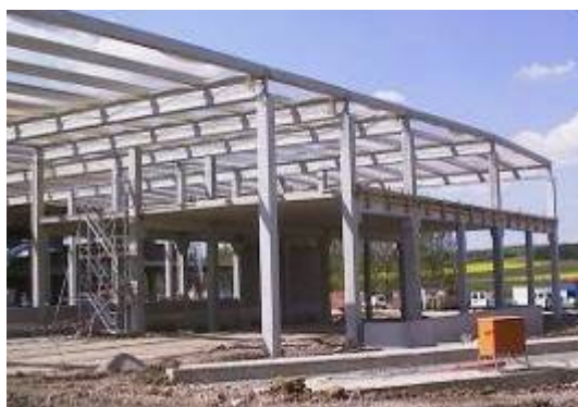
Halls et bureaux Wavelux à Munsbach (L) 223 000 m 3
