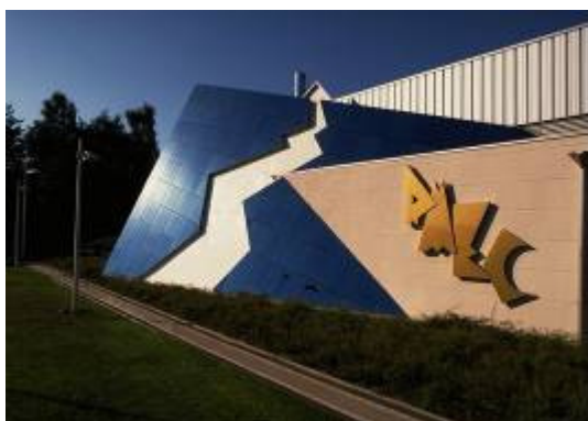
Centrale de cogénération urbaine à Creutzwald (F)
