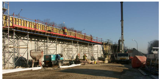
Ouvrage de soutènement (F)
