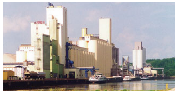
Silos portuaires (F)
